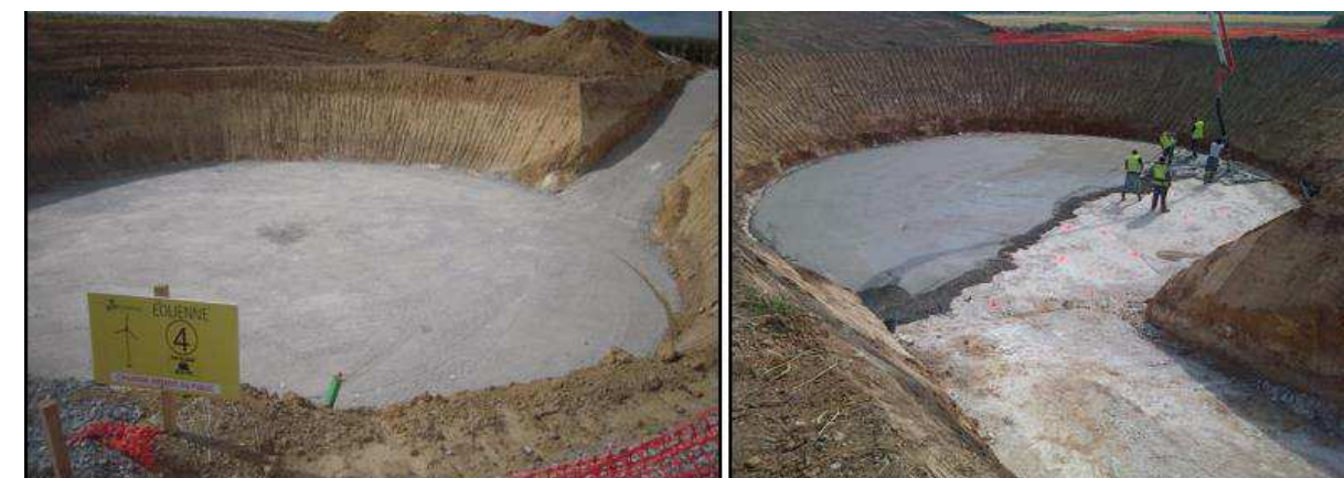
Photographie 3 et Photographie 4 : Mise en place du béton de propreté des fondations du parc de Caix
